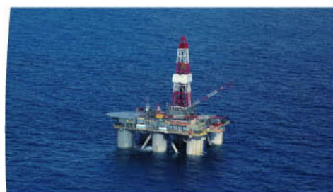
炼油厂、海上钻井平台、控制机房、 循环液泵、无线电系统
